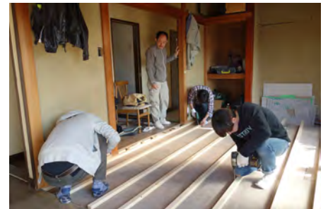
空家リノベーション・プロジェクト (空家の有効利用)
